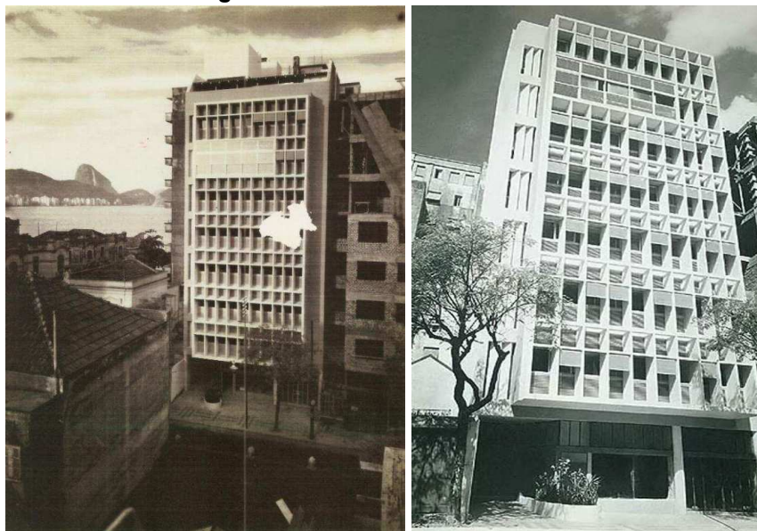
Figura 45 - Edifício MMM Roberto
