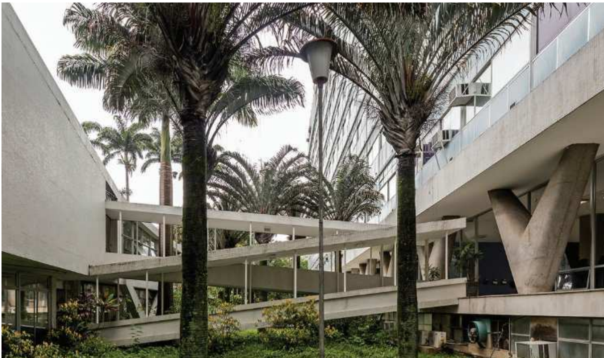
Figura 38 - Rampa ligando os volumes no Hospital da Lagoa
