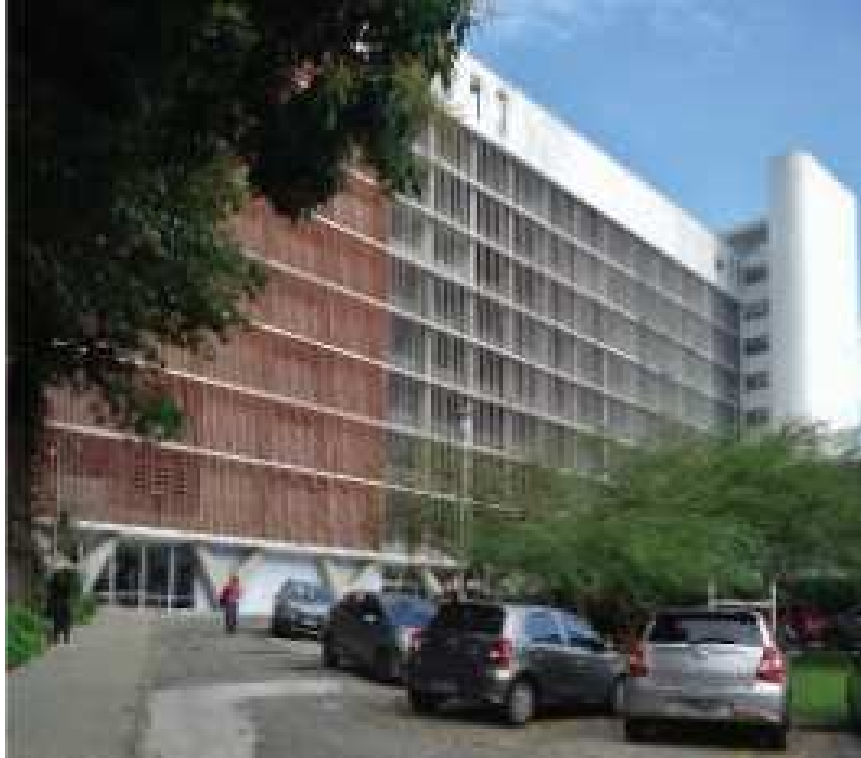
Figura 36 - Fachada Noroeste Hospital da Lagoa
