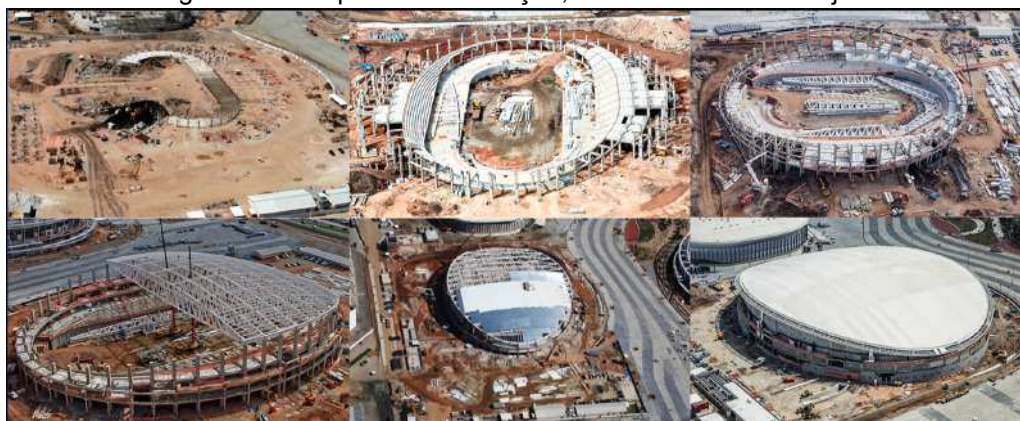
Fotografia 15: Etapas de Construção, Velódromo do Rio de Janeiro
