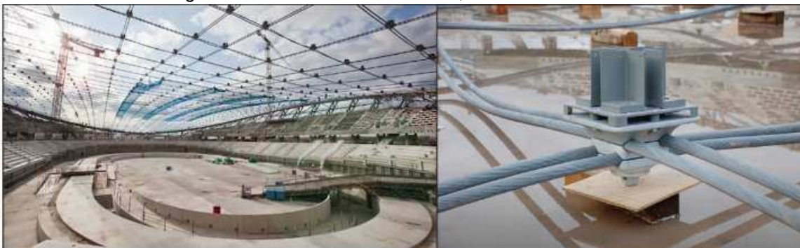
Fotografia 10: Estrutura da Cobertura, Velódromo de Londres
