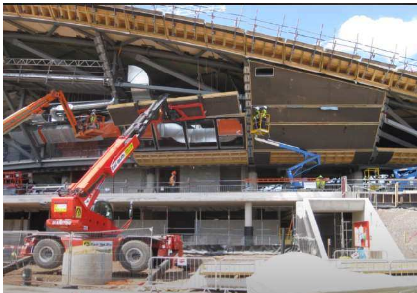
Fotografia 11: Instalação placas térmicas
