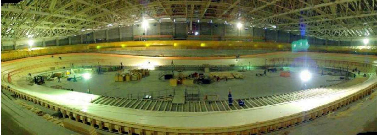
Fotografia 12: Montagem Pista, velódromo do Rio de Janeiro
