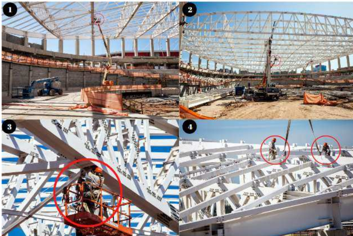
Fonte: Recuperação da cobertura do velódromo do Rio de Janeiro
