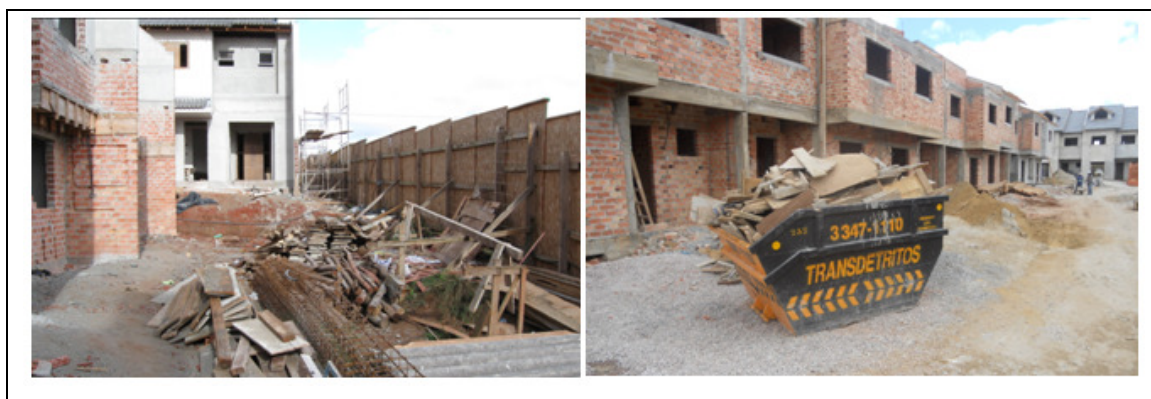
Figura 8 – Fotos da organização da obra antes e depois da implantação do SG-HSSMAT Fonte: Dados do autor, 2011.
