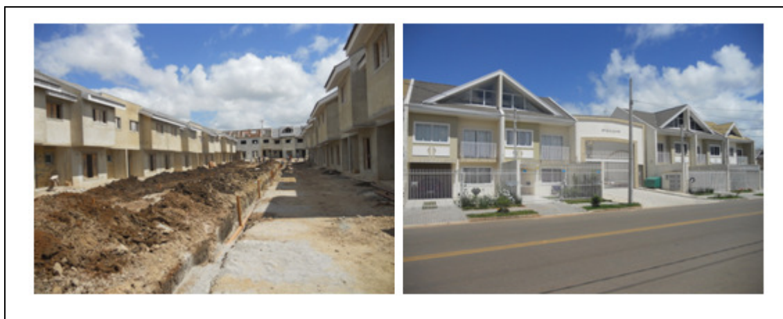
Figura 4 – Fotos de obras construídas pela empresa pesquisada Fonte: Do autor, 2011.
