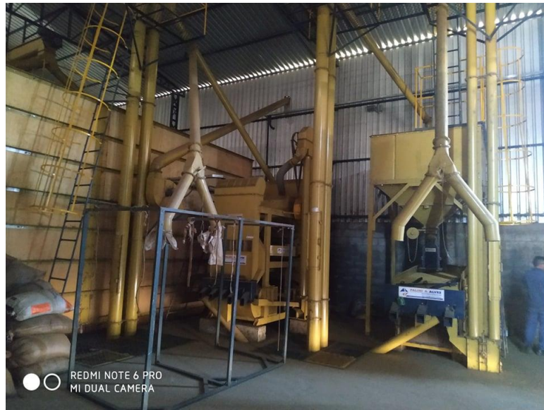
Figura 23 – Detalhe barracão de beneficiamento, parte do reservatório de armazenamento.
