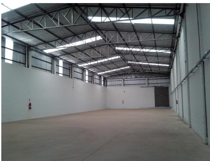
Figura 27 – Exemplo de aplicação de telhas de acrílico.
