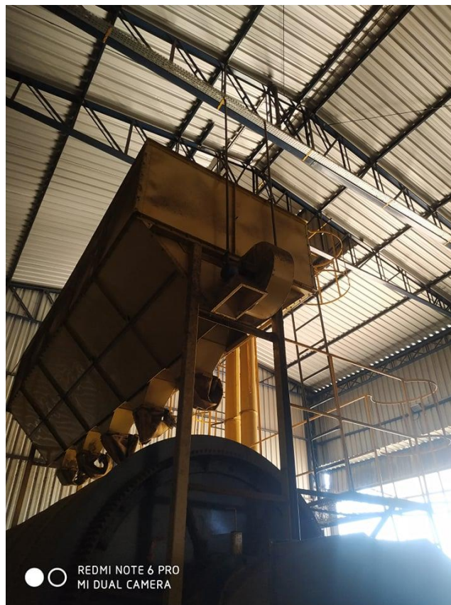
Figura 24 – Detalhe barracão de beneficiamento, reservatório de secagem.
