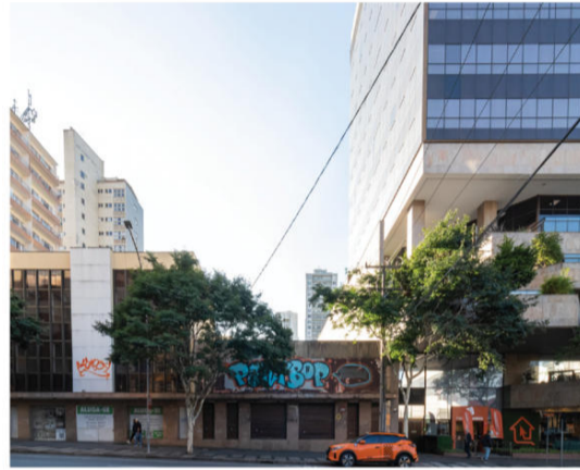
Construções vizinhas subutilizadas na testada da Rua Marechal Deodoro.
