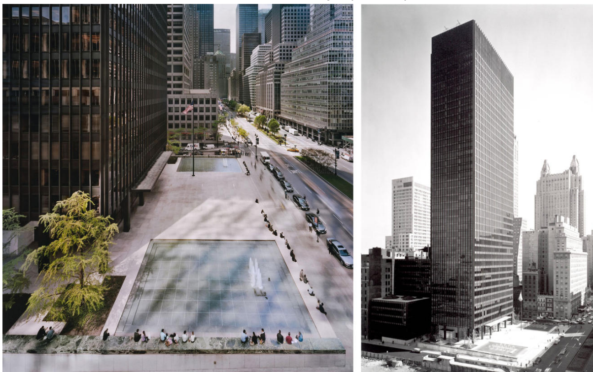
Figura 11 - Praça formada no plinto do Seagram Building (a esquerda) e o edifício em seu contexto em Nova Iorque (a direita).
