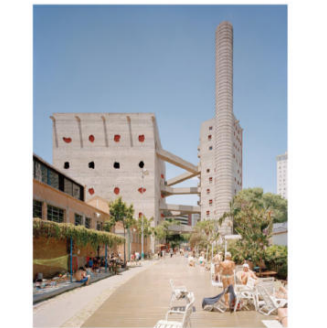
Solário do SESC Pompéia, o interstício entre a antiga fábrica e o anexo de concreto aparente, com suas passarelas de conexão entre a circulação vertical e sanitários, com as quadras e piscina. Fotografia de: Ciro Miguel (2018)
