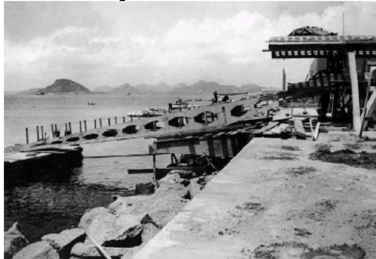
Figura 30 – Acesso ao cais.
