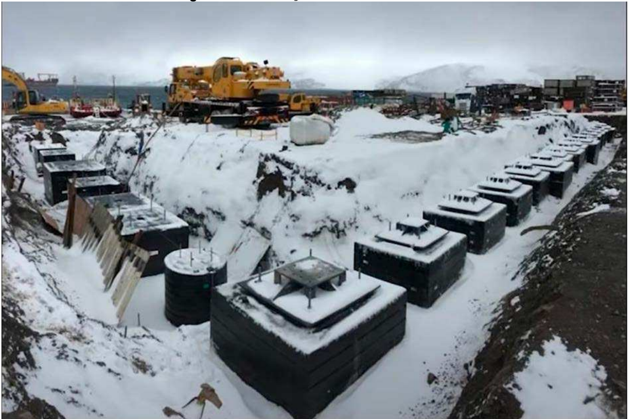
Figura 50 – Fundação do Bloco Técnico.
