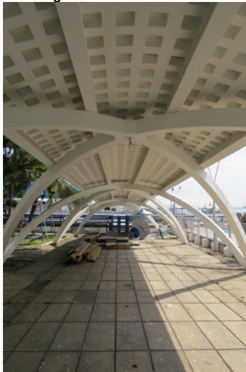
Figura 29 – Acesso ao cais.
