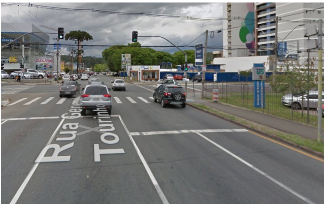
Figura 23 – Faixa de retenção mais longe do cruzamento Fonte: Google Street View
