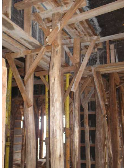
Figura 21 – Sistemas de escoramento misto (em madeira e em metálica).
