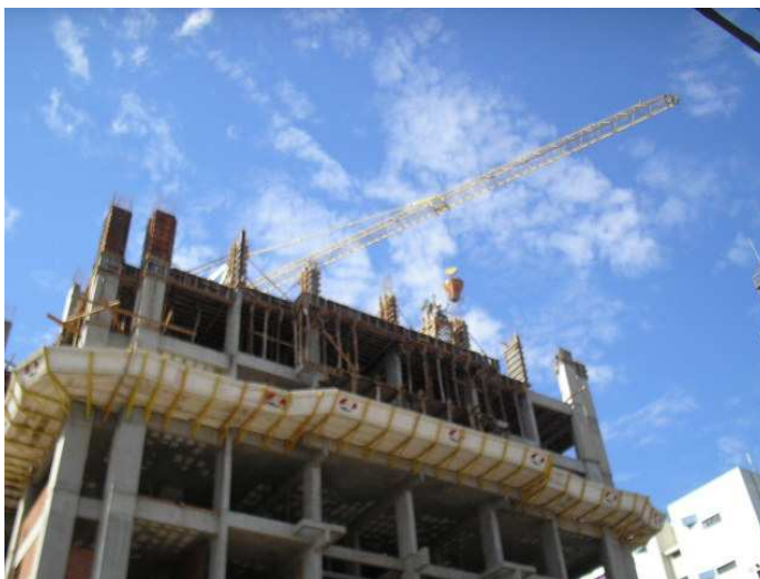
Figura 17 – Ajuda da grua para concretagem de pilares, que foi realizada com o sistema de caçamba para elevação de cargas.
