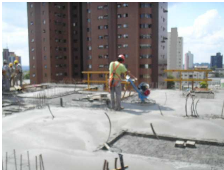
Figura 23 – Máquina niveladora da laje após concretagem.
