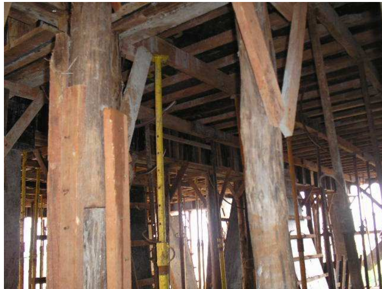
Figuras 22 – Sistemas de escoramento misto (em madeira e em metálica).
