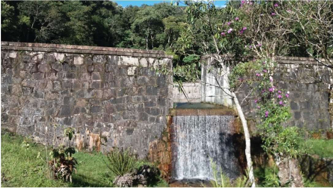
Fotografia 6 - Reservatório do Carvalho
