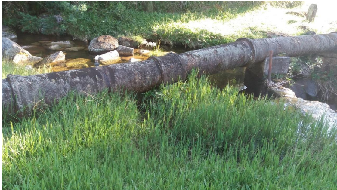
Fotografia 8 – Adutora do Reservatório do Carvalho
