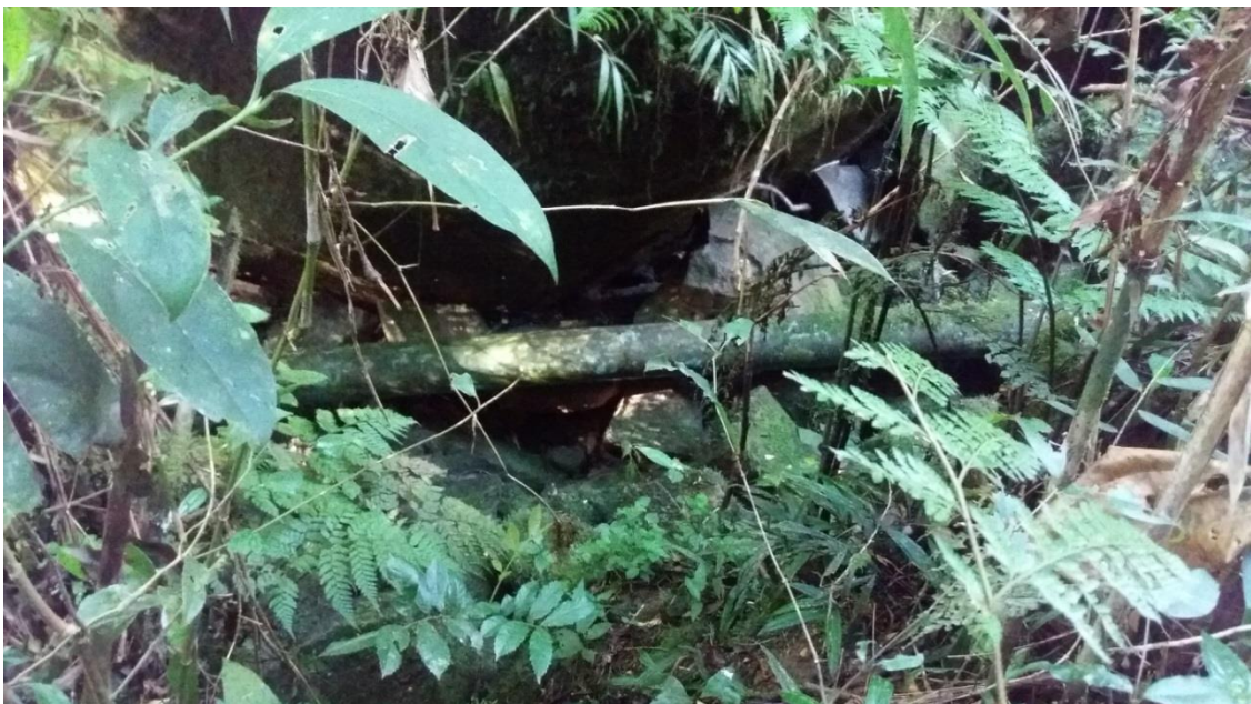
Fotografia 7 – Adutora do Reservatório do Carvalho
