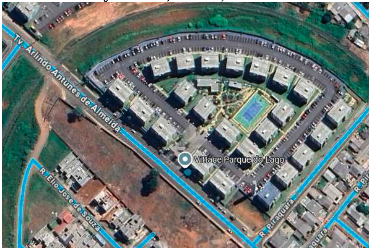
Figura 1: Localização da edificação de estudo.
