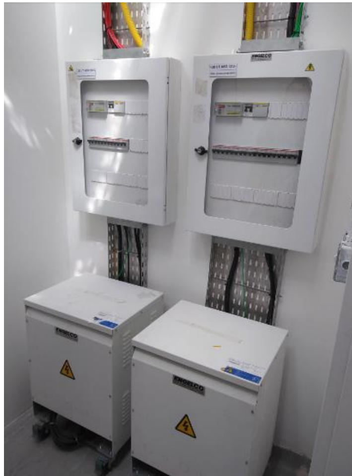
Fotografia 5 – Sala técnica do sistema IT-Médico
