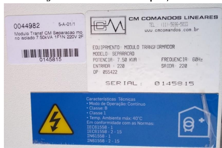
Fotografia 2 - Transformador de separação 220V
