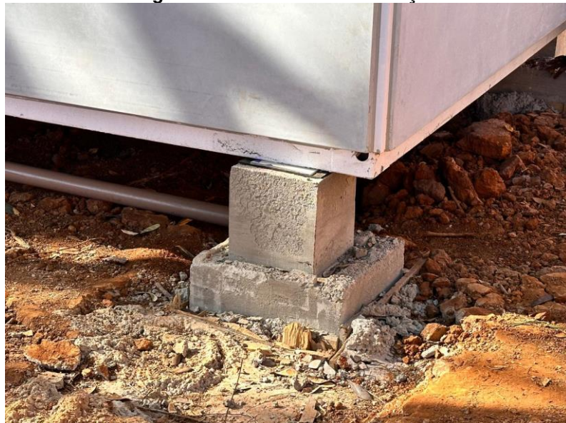
Figura 15 - Elemento de fundação
