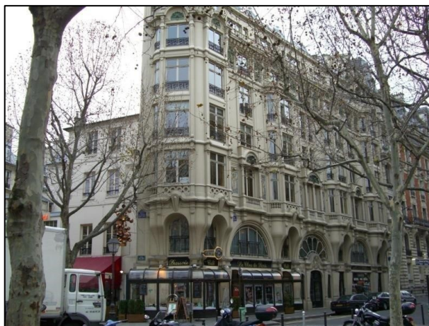
Figura 6 – Primeiro Edifício do mundo construído no sistema Hennebique.
