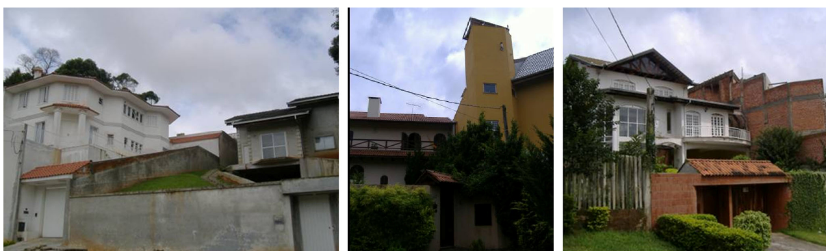
Figura 40 – Exemplos de obstruções ao acesso solar em edificações adjacentes causadas pela utilização máxima do potencial construtivo permitido em zonas residenciais em Curitiba.
