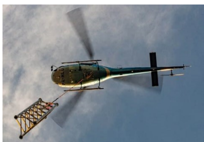
Construção de Linha de Transmissão
