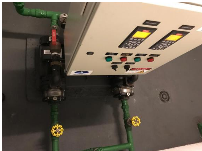
Figura 1 – Sistema de pressurização de água potável
