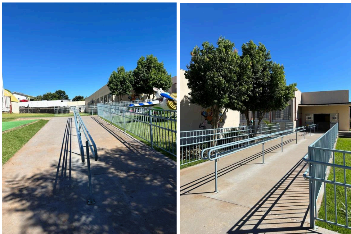
Imagem 2 – Rampa de acesso à escola
