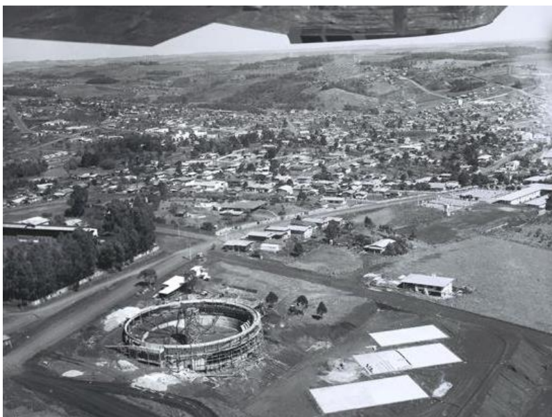
e) Vista aérea do início da construção do Ginásio Dolivar Lavarda, início da década de 1980;
