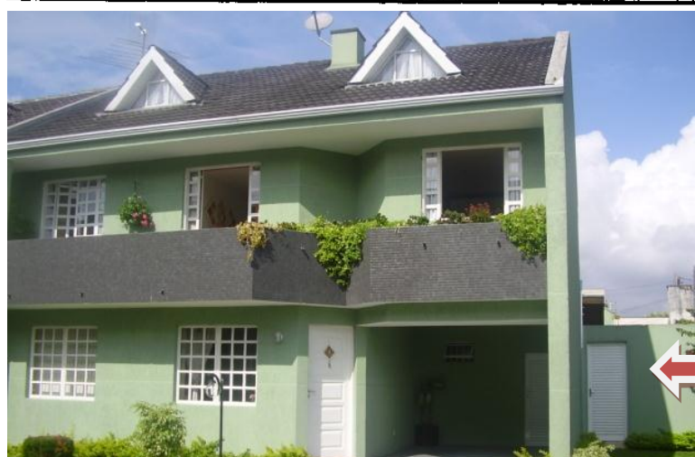
Figura 56 - Desenho e foto da vista frontal original, de sobrado do conjunto habitacional Isla Victoria
