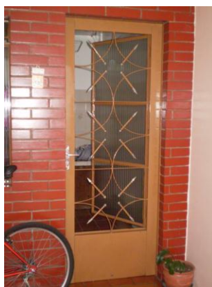
Figura 52– Nova configuração entre garagem e lavanderia de moradia do conjunto Gurupi Fonte: Foto de autoria própria.
