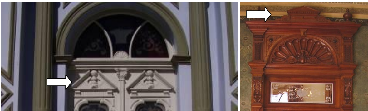
Figura 17 - Portas do Palacete dos Leões, em Curitiba, com detalhes de frontão Fonte: Fotos de autoria própria.
