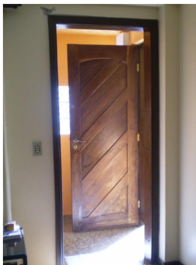
Figura 62 - Hall construído para abrigar porta de acesso principal em moradia do conjunto habitacional Panamericano
