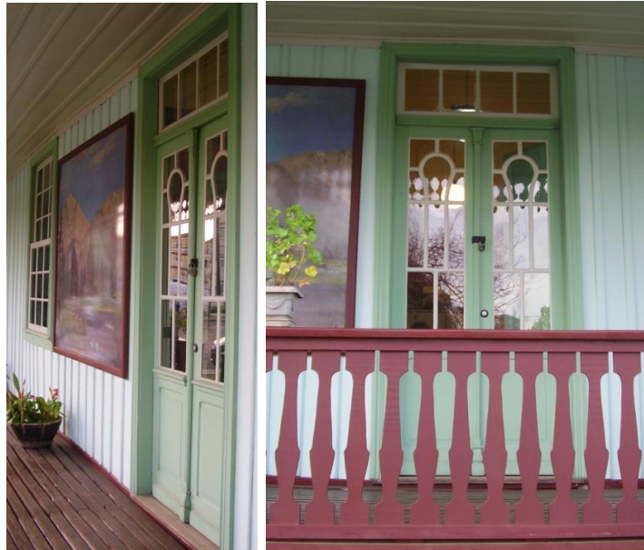
Figura 12 - Detalhe de porta de moradia, atualmente sede do IPHAN em Curitiba Fonte: Fotos de autoria própria.
