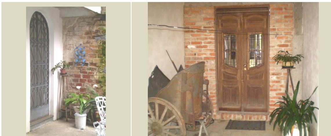
Figura 49 - Portas de demolição, restauradas e instaladas em moradia do bairro Jardim das Américas Fonte: Fotos de autoria própria.
