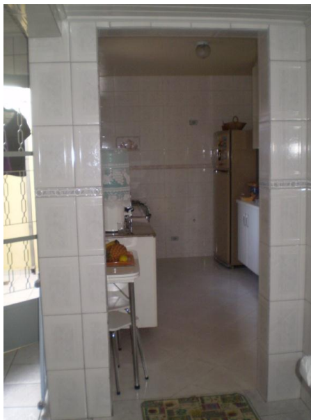
Figura 68 – Vão de passagem onde antes existia uma porta entre cozinha e lavanderia na moradia P5 do conjunto habitacional Panamericano
