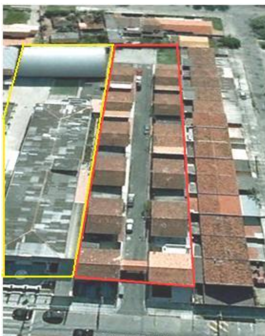
Figura 53 - Vista aérea do conjunto habitacional Gurupi no bairro Cajuru
