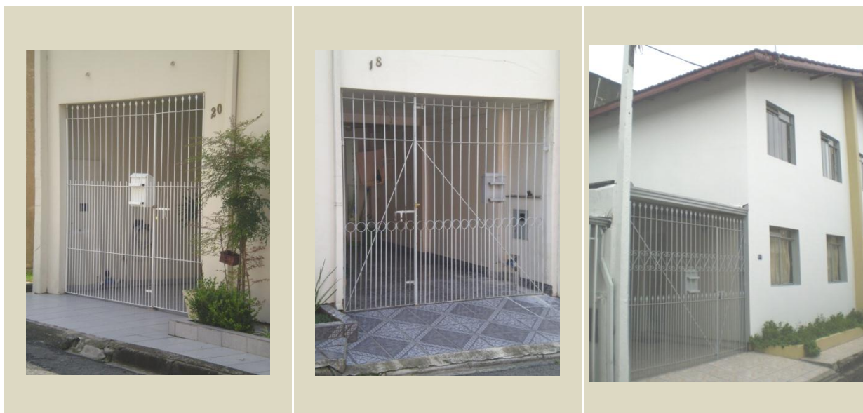
Figura 63 – Portas de segurança instaladas em moradias do conjunto Gurupi
