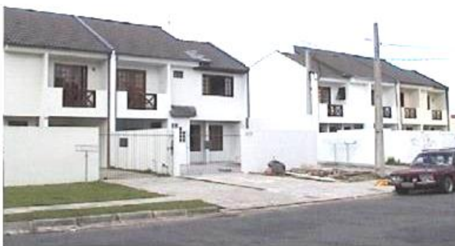
Figura 41 - Configuração de sobrados 159/1, 159/2, 159/3, 159/4 do conjunto habitacional Panamericano no bairro Capão da Imbuia
