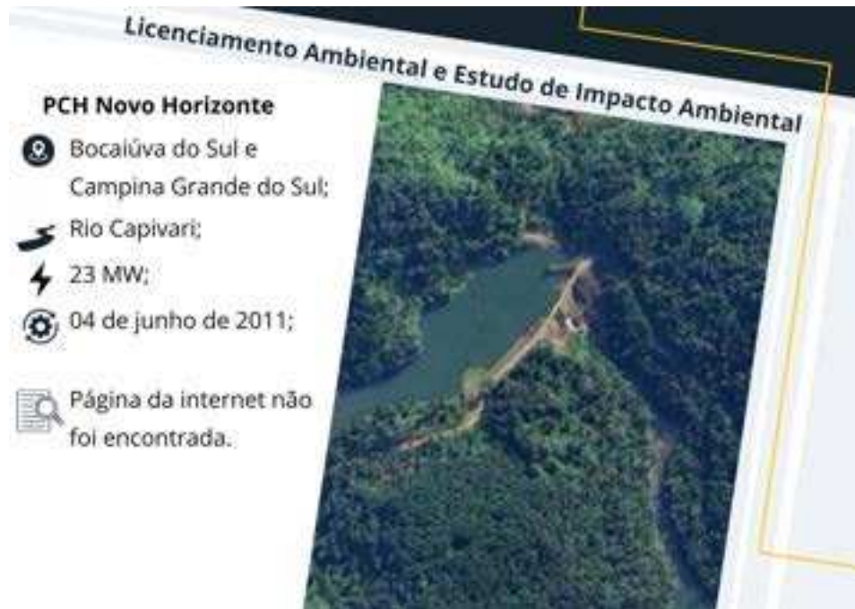
Figura 20 – Vista Aérea da PCH Novo Horizonte
