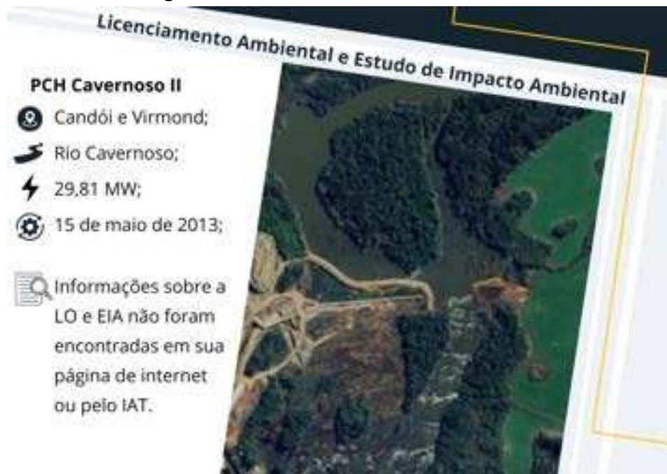
Figura 13 – Vista Aérea da PCH Cavernoso II
