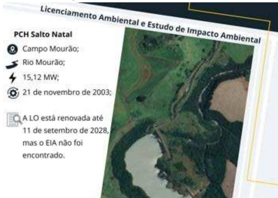
Figura 24 – Vista Aérea da PCH Salto Natal
