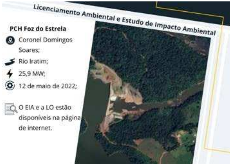
Figura 17 – Vista Aérea da PCH Foz do Estrela
