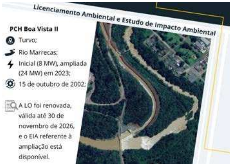
Figura 10 – Vista Aérea da PCH Boa Vista II
