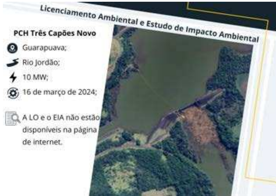
Figura 26 – Vista Aérea da PCH Três Capões Novo
