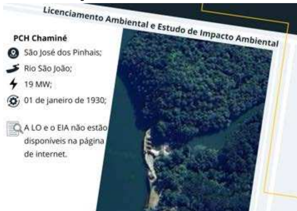
Figura 14 – Vista Aérea da PCH Chaminé
