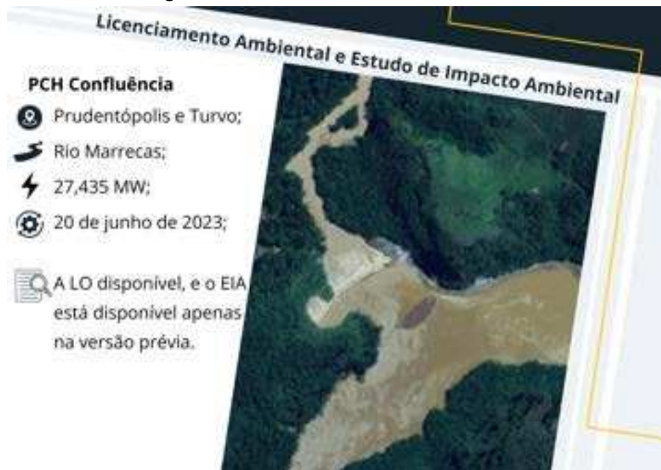
Figura 15 – Vista Aérea da PCH Confluência
