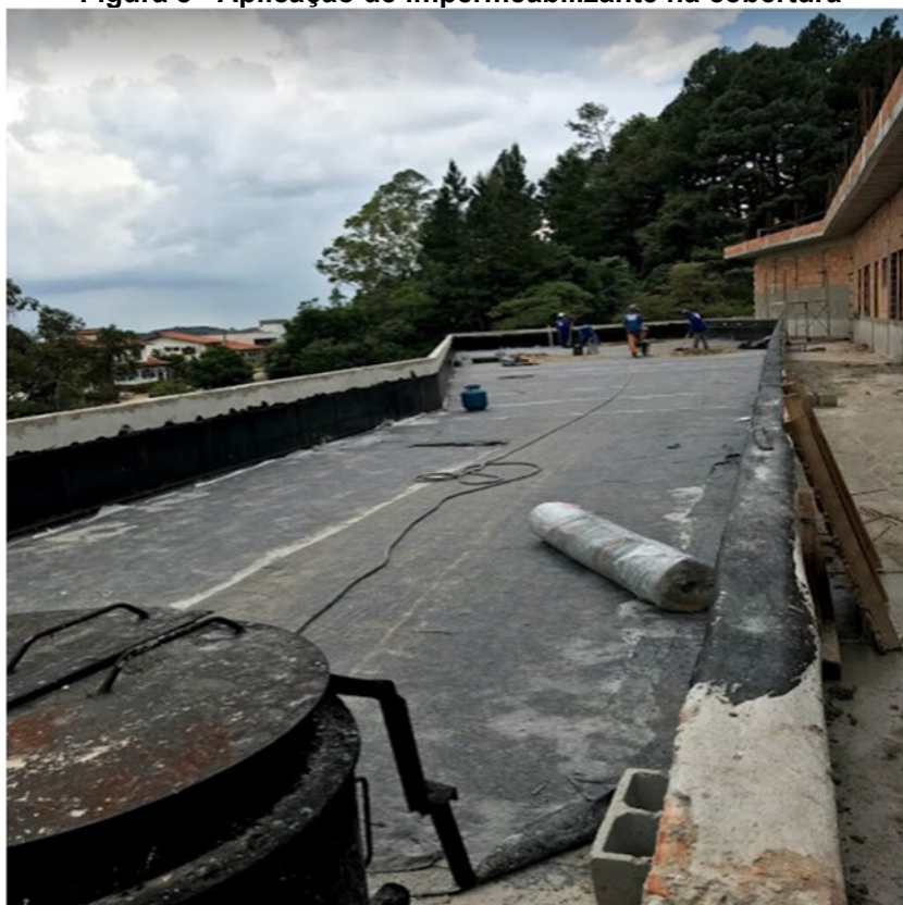
Figura 8 - Aplicação de impermeabilizante na cobertura
