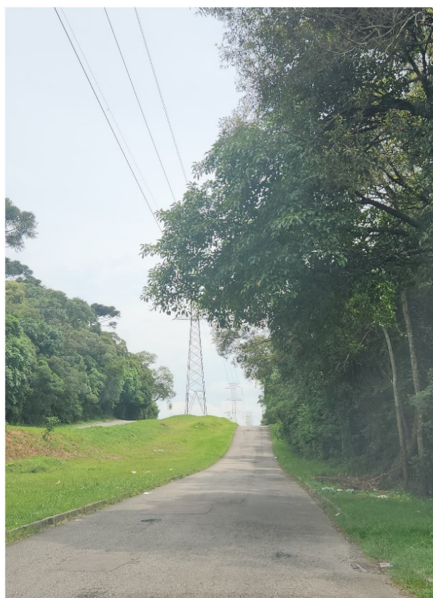
Figura 9 - Faixa de Alta Tensão na Vila Terra Santa em 2023
