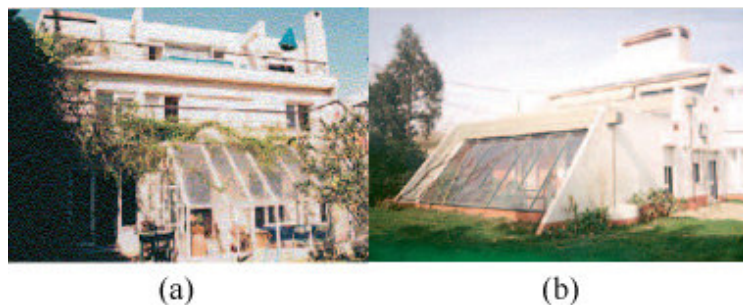
FIGURA 11- Exemplo de utilização de estufa em Portugal, (a) moradia do Vale do Rosal, Arq. Fausto Simões; (B) moradia da cidade do Porto, Arq. Fernanda Seixas
