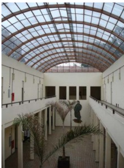
FIGURA 4 - Pátio da Oficina Cultural Oswald de Andrade, em São Paulo – SP, onde são utilizadas aberturas zenitais
