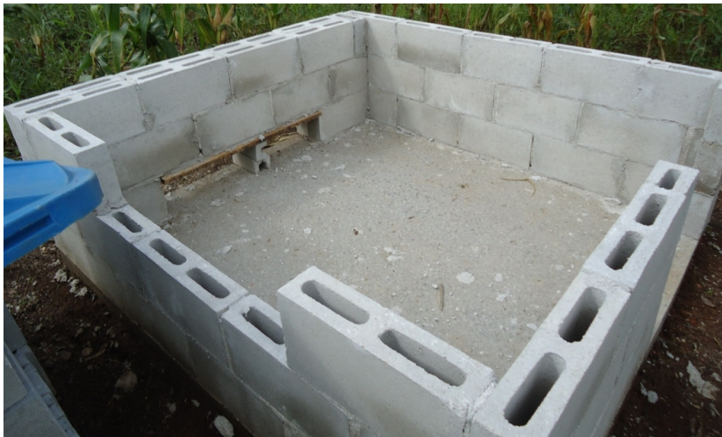
FIGURA 23 - Protótipo construído com blocos de concreto.
