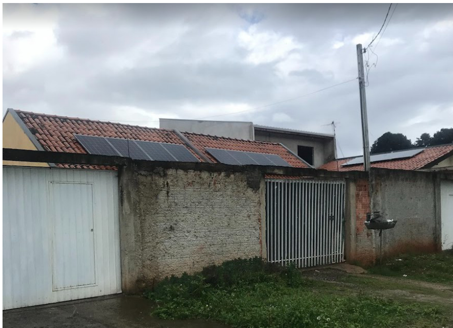
Figura 25 – Painéis solares instalados no telhado das HIS do Moradias Faxinal
