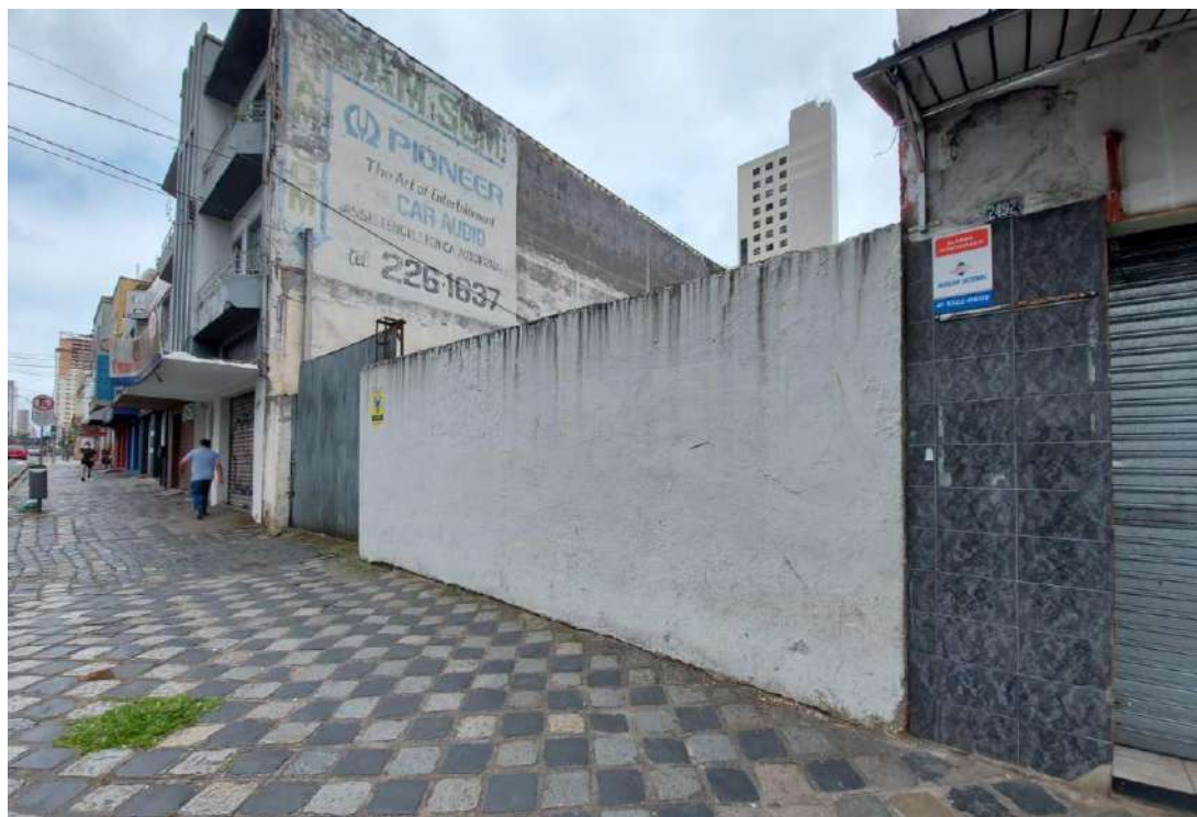
Figura 20: Fachada do terreno para a Avenida Visconde de Guarapuava.
