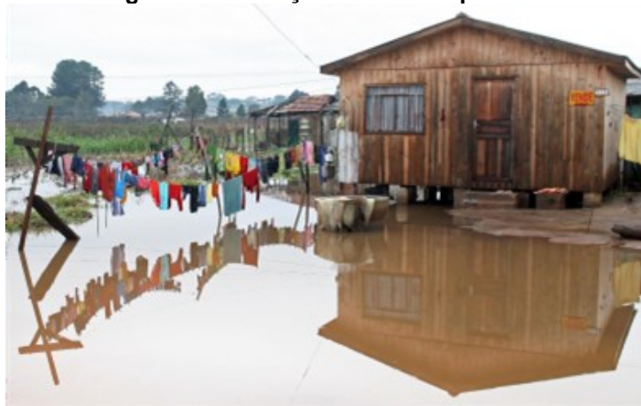
Figura 7 - Habitação em estado precário
