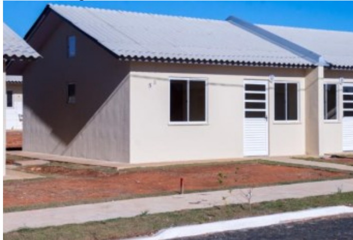
Figura 6 - Habitação em bom estado
