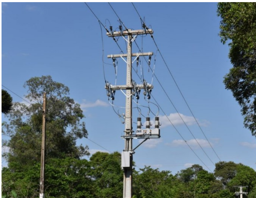
Figura 12: Religador automático na rede
