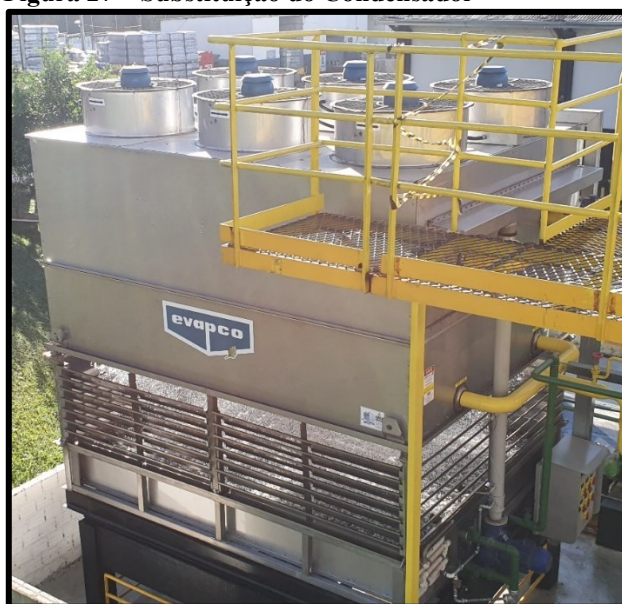
Figura 27 – Substituição do Condensador
