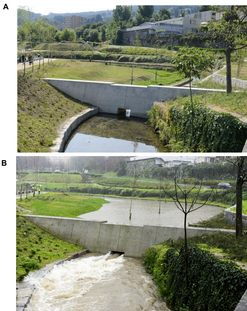
Figura 10 - Bacia de contenção em período de estiagem
