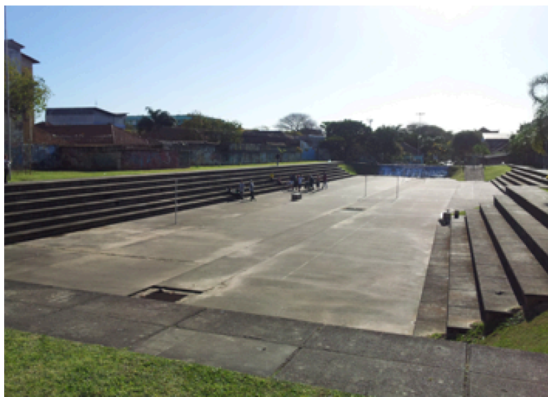
Figura 13 - Reservatório de detenção a céu aberto
