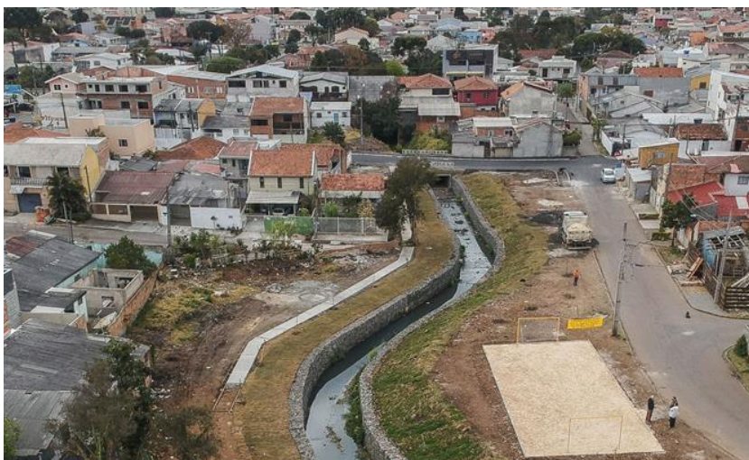
Figura 4 - Representação de um sistema de macrodrenagem
