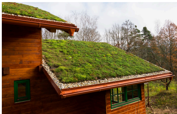
Figura 5 - Exemplo de telhado verde
