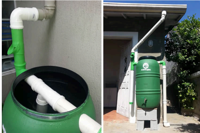
Figura 7 - Implantação de uma cisterna
