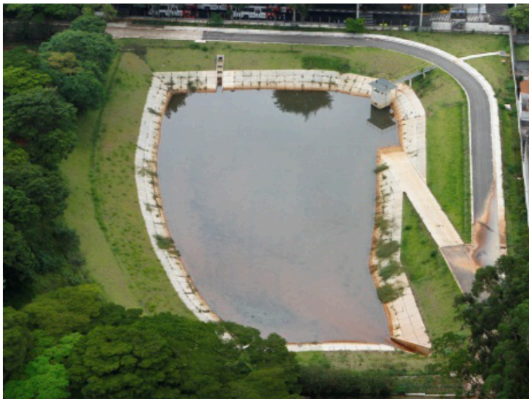
Figura 12 - Reservatório de retenção a céu aberto
