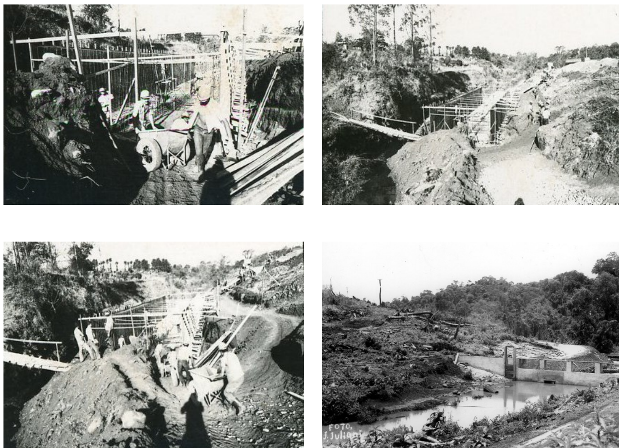
Figura 9 - Construção da barragem do Lago Igapó I
