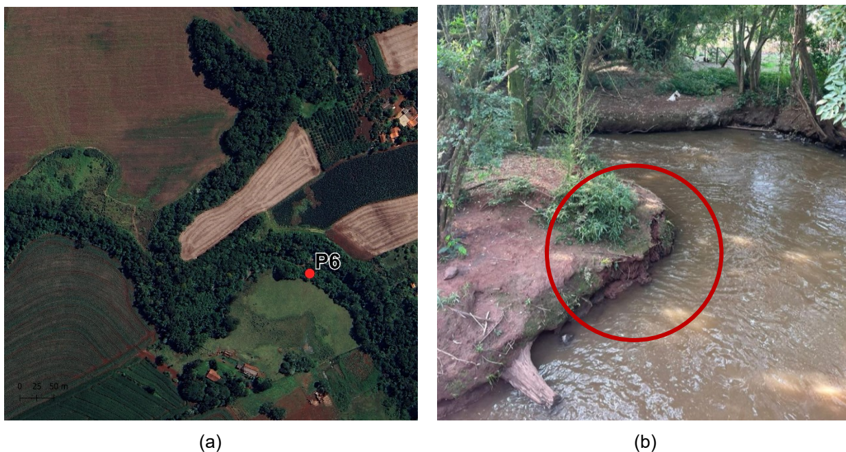
Figura 35 - Ponto 6 (P6) de amostragem do Protocolo de Avaliação Rápida Urbana na Bacia Hidrográfica do Ribeirão Cambé. A) Localização espacial do ponto. B) Registro fotográfico com destaque em círculo vermelho processo erosivo de margem
