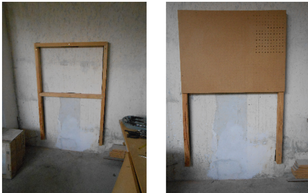
Figura 20 – Finalização do quadro e painel de MDF Fonte: Autora (2017).
