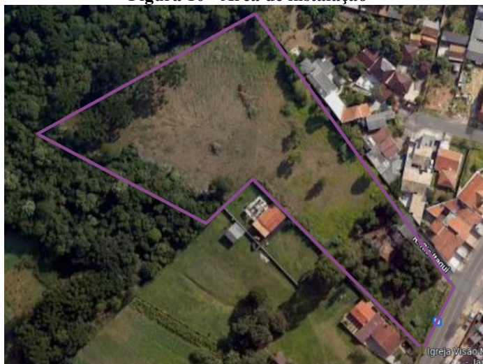
Figura 10 - Área de instalação
