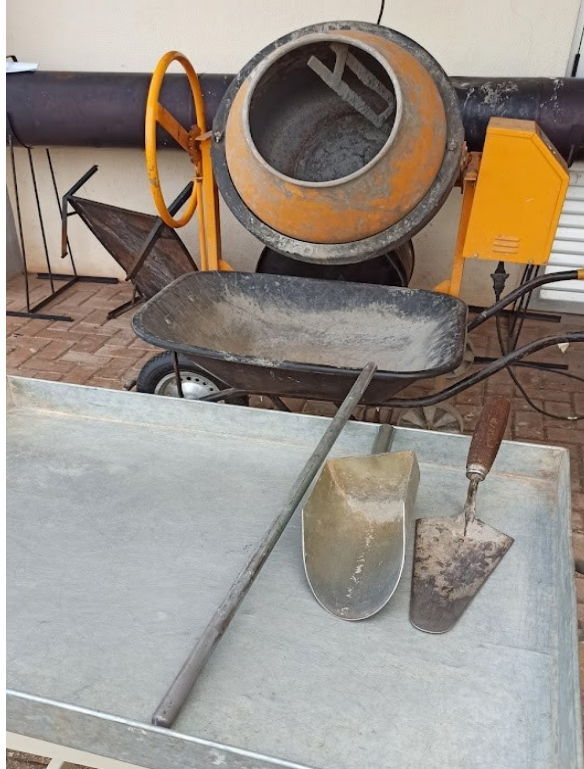
Fotografia 3 - Equipamentos e ferramentas utilizadas
