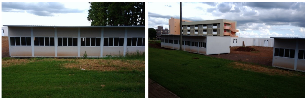
Figura 31: Fotografias gerais externas do bloco modular administrativo da UTFPR Toledo
