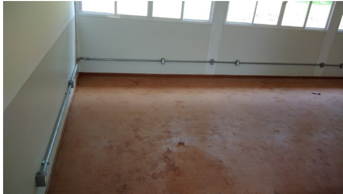
Figura 32: Fotografia de área interna do bloco modular administrativo da UTFPR Toledo
