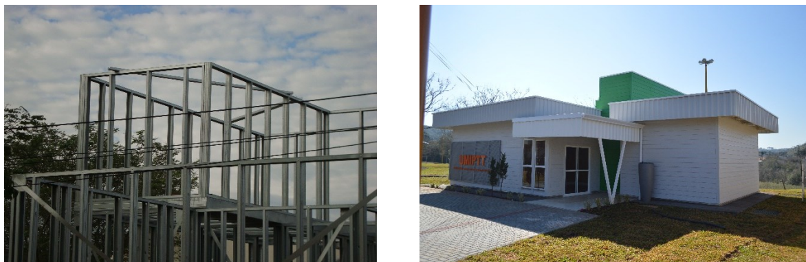
Figura 28: Fotografias da edificação em construção (esquerda) e da edificação pronta (direita)
