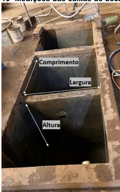
Figura 19- Medições das caixas de decantação
