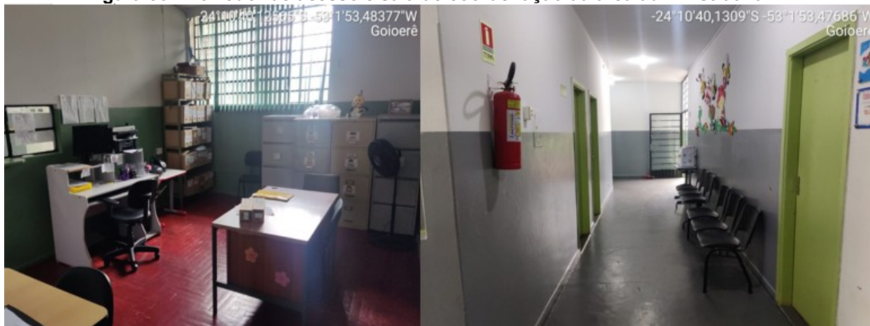
Figura 56 - Corredor de acesso e sala de coordenação da área administrativa
