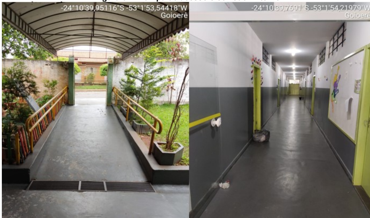
Figura 54- Rampa de acesso e corredor interno
