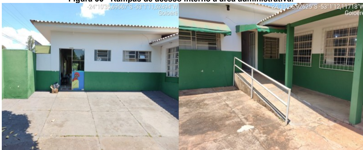
Figura 35 - Rampas de acesso interno a área administrativa.
