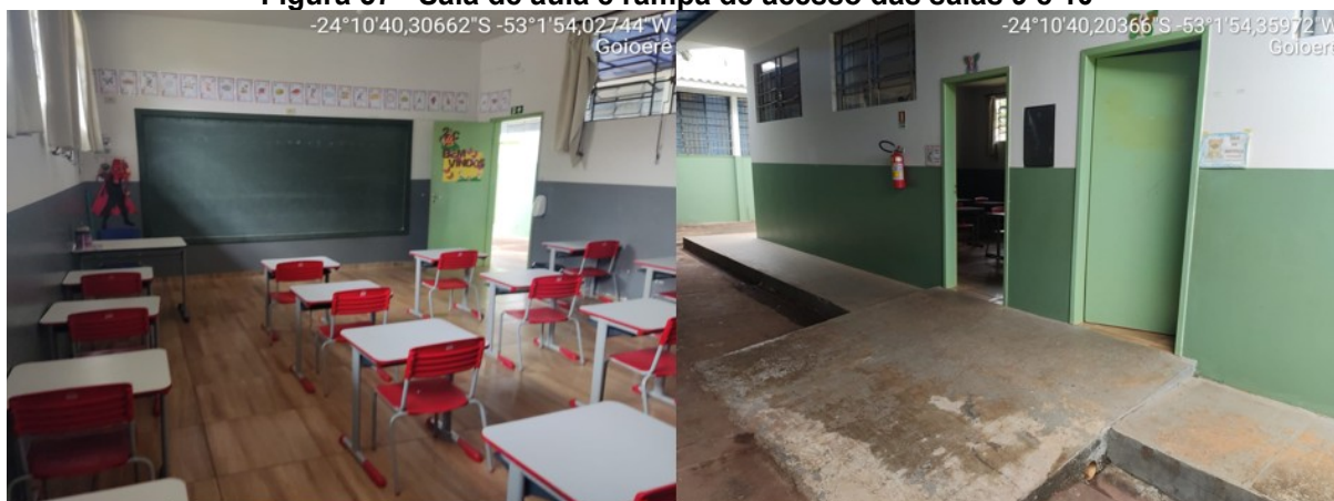
Figura 57 - Sala de aula e rampa de acesso das salas 9 e 10
