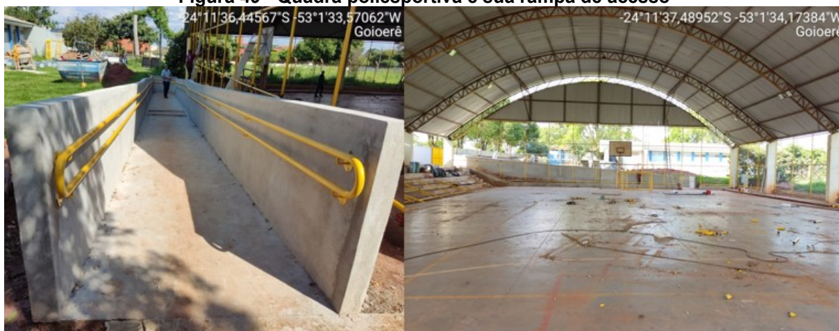
Figura 49 - Quadra poliesportiva e sua rampa de acesso
