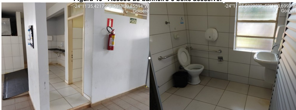
Figura 46 - Acesso ao banheiro e boxe acessível
