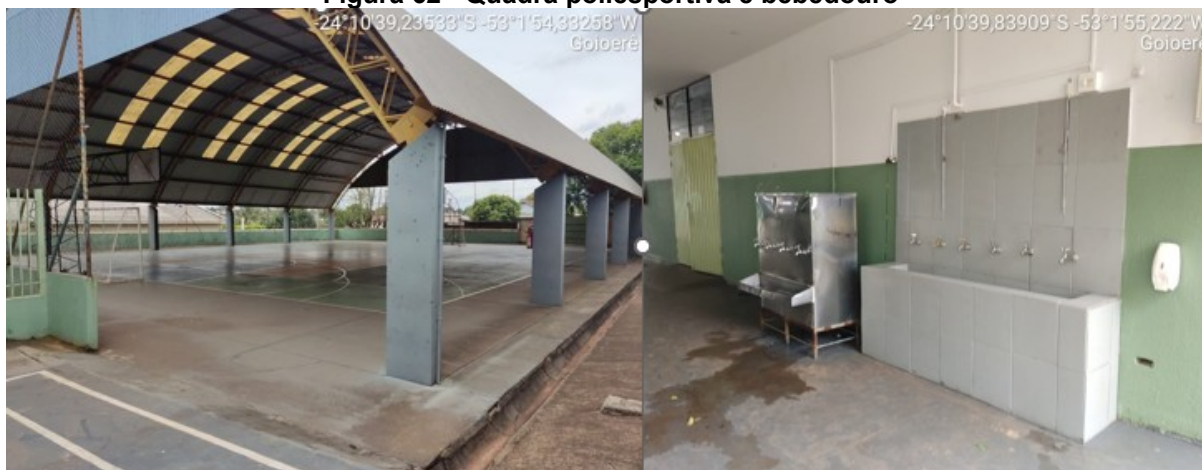
Figura 62 - Quadra poliesportiva e bebedouro
