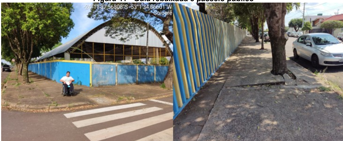
Figura 41 - Guia rebaixada e passeio público
