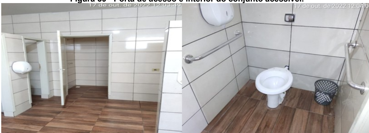
Figura 39 - Porta de acesso e interior do conjunto acessível.
