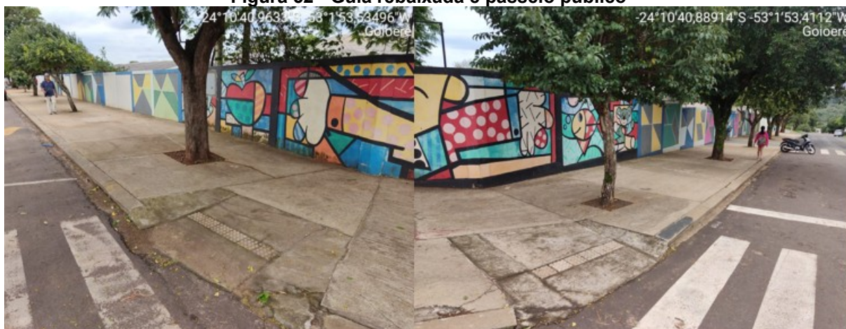
Figura 52 - Guia rebaixada e passeio público
