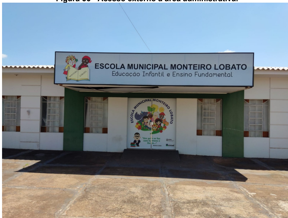
Figura 36 - Acesso externo a área administrativa.
