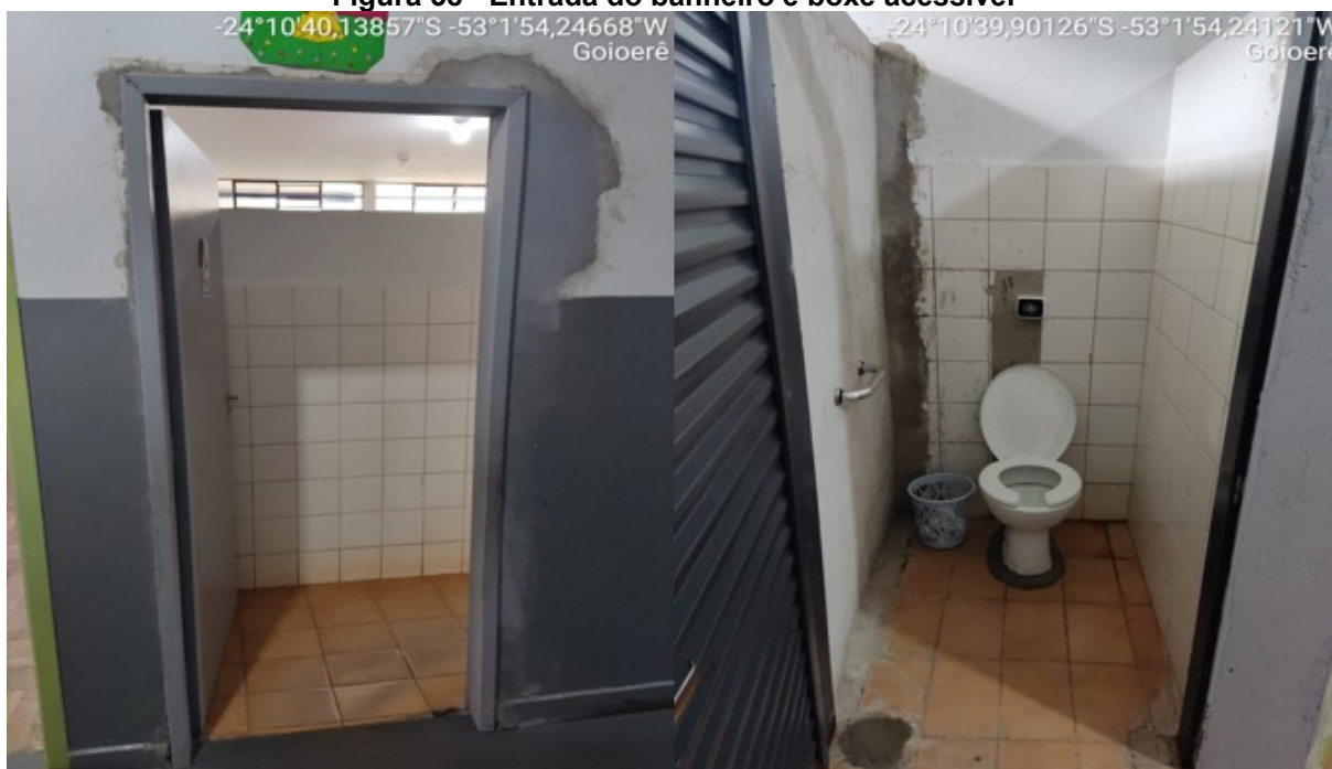
Figura 58 - Entrada do banheiro e boxe acessível
