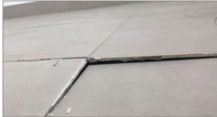
Figura 3 - Estufamento de placas cerâmicas.
