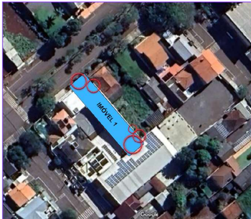
Figura 33 - Localização das patologias no imóvel vistoriado.
