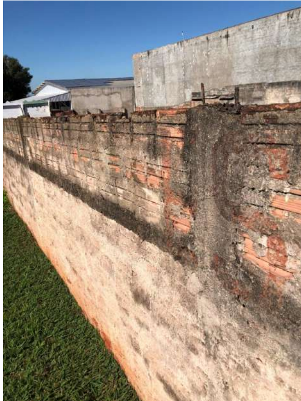
Figura 36 - Muro de divisa do imóvel.
