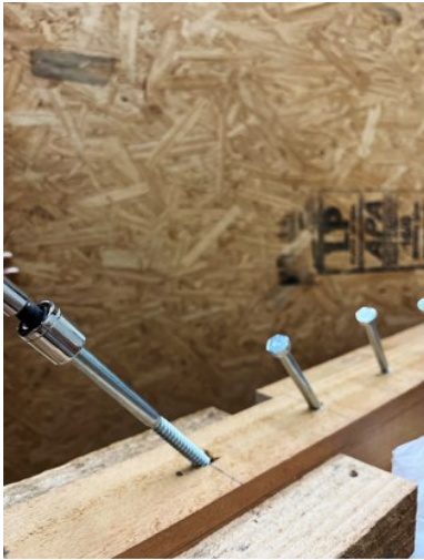
a) Instalação dos parafusos
