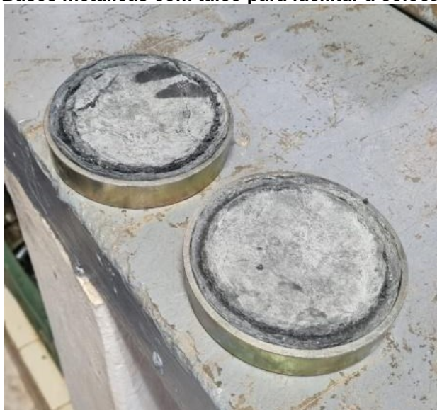
Fotografia 14: Bases metálicas com talco para facilitar a colocação dos discos
