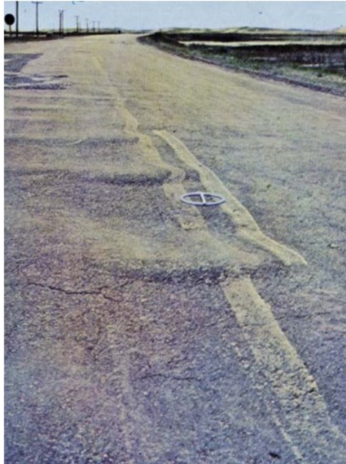
Figura 7 – Ondulação/Corrugação
