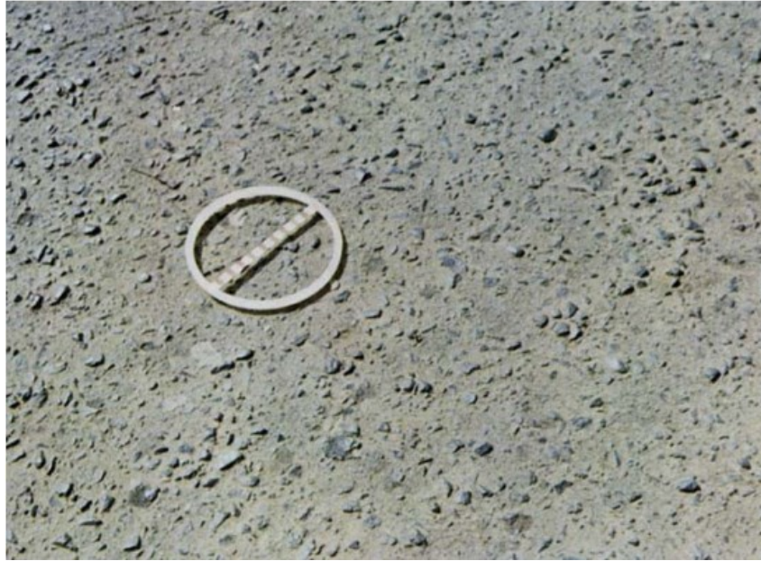
Figura 10 – Desgaste
