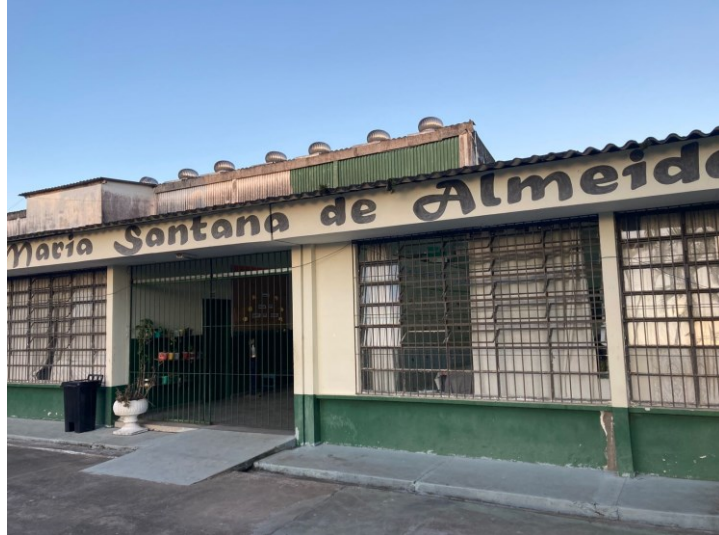
Fotografia 1 – Fachada interna da Escola Maria Santana de Almeida
