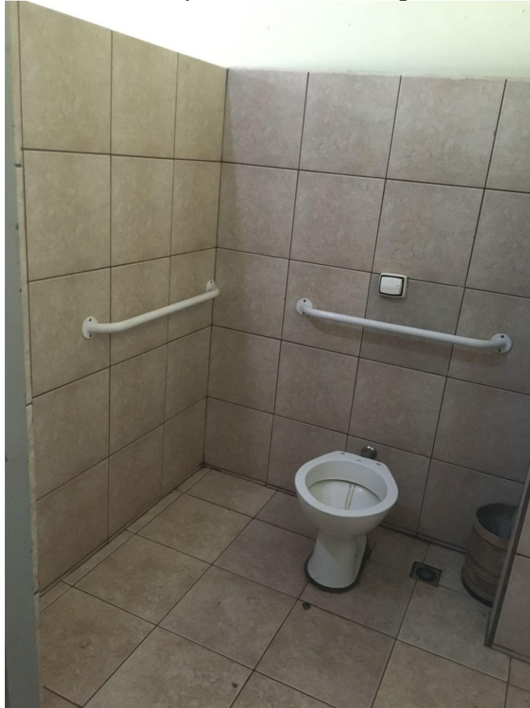
Fotografia 11 – Banheiro feminino para deficientes do Colégio Estadual 14 de Dezembro.
