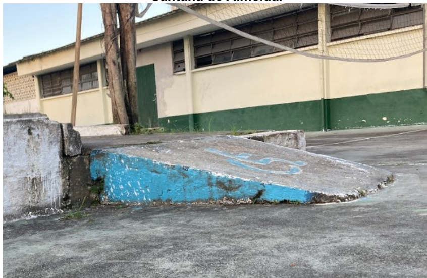
Fotografia 24 – Rampa de acesso a área inativa da escola e quadra esportiva da Escola Maria Santana de Almeida.
