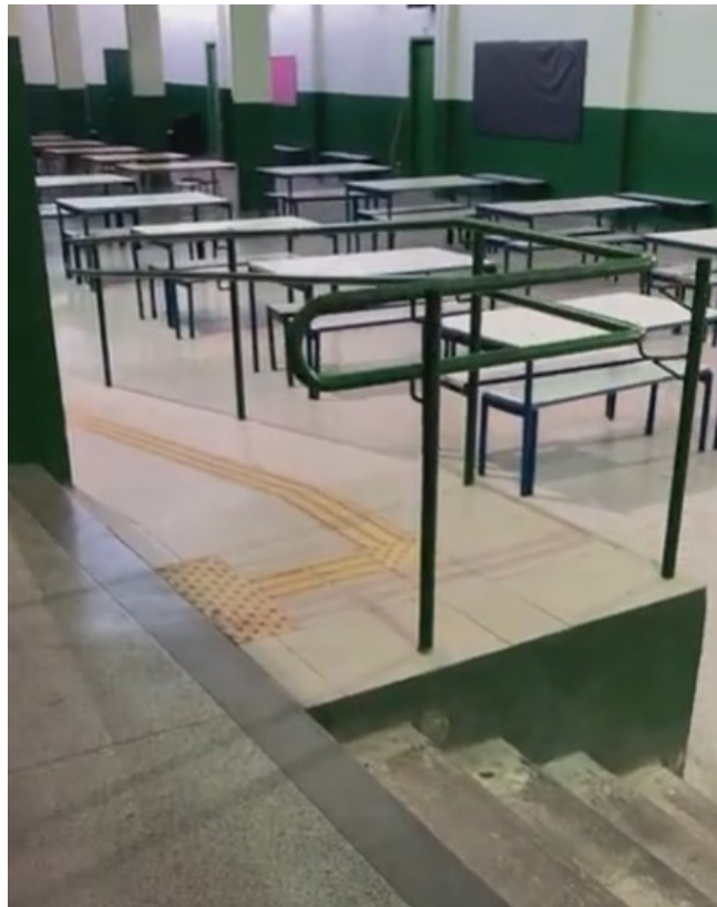
Fotografia 20 – Rampa nova construída baseada na NBR 9050:2020 da Escola Maria Santana de Almeida.
