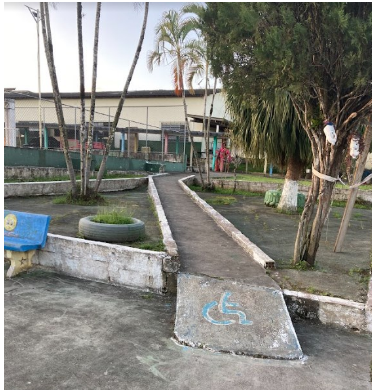
Fotografia 26 – Acesso à área desativada da Escola Maria Santana de Almeida.
