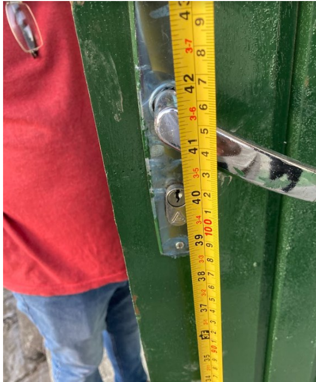
Fotografia 18 – Medição da altura de uma das maçanetas do tipo alavanca da Escola Maria Santana de Almeida.
