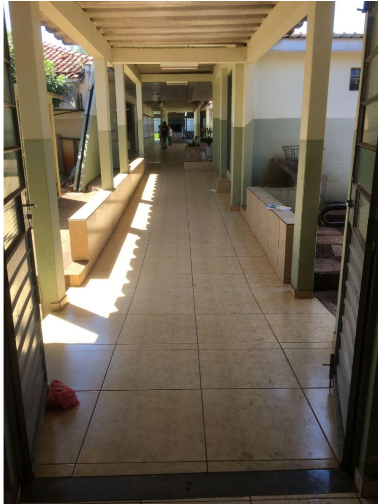
Fotografia 7 - Rampa que conecta o bloco das salas com o pátio no Colégio Estadual 14 de Dezembro.
