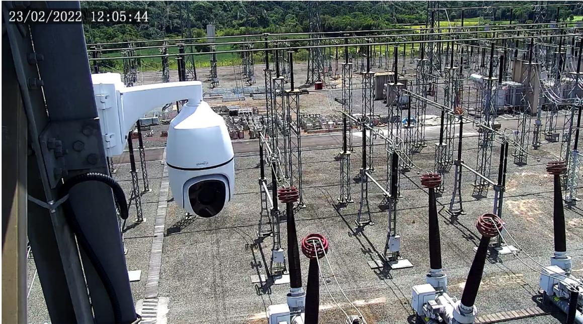
Figura 27 – Uma das cinco câmeras instaladas em uma das torres próximas ao circuito “Areia” na Subestação Bateias.
