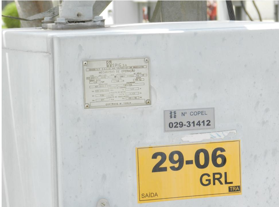
**Figura 33 – Identificador de um conjunto de chaves seccionadoras, posicionado na caixa do seu circuito de comando.**
