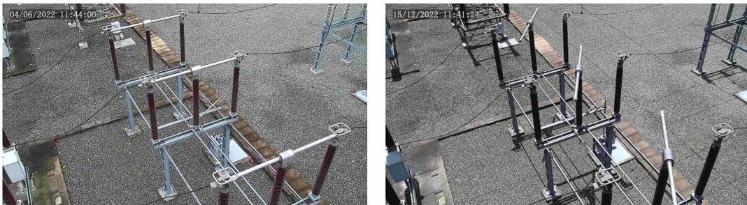
**Figura 32 – Comparação entre o aspecto de um conjunto de chaves em seu estado usual (fechado), à esquerda, com seu estado manobrado (aberto), à direita. As manobras foram realizadas com o objetivo de capturar imagens exclusivamente para teste da solução proposta.**
