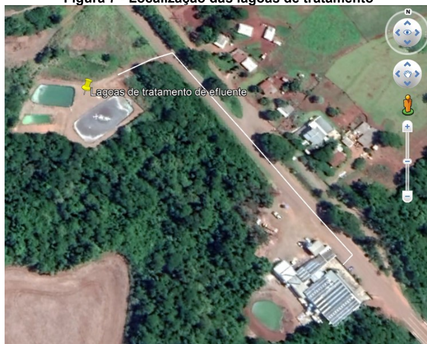
Figura 7 - Localização das lagoas de tratamento
