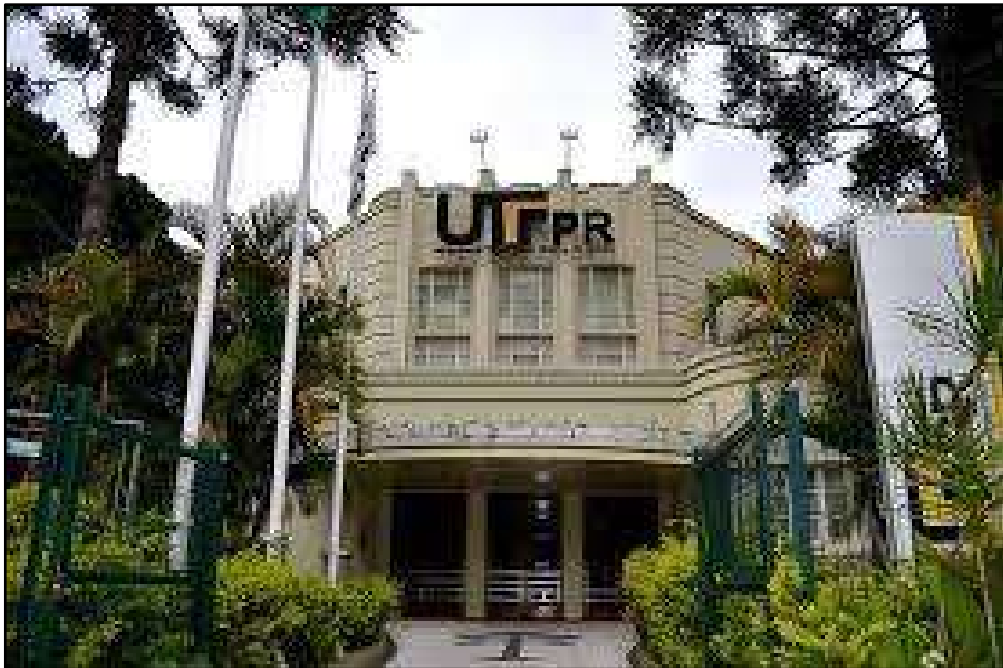
Figura 8 - Fachada atual da sede da Reitoria da UTFPR
