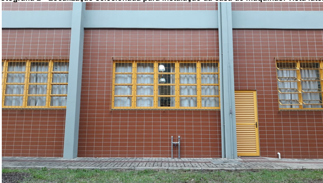
Fotografia 2 - Localização selecionada para instalação da casa de máquinas: vista lateral
