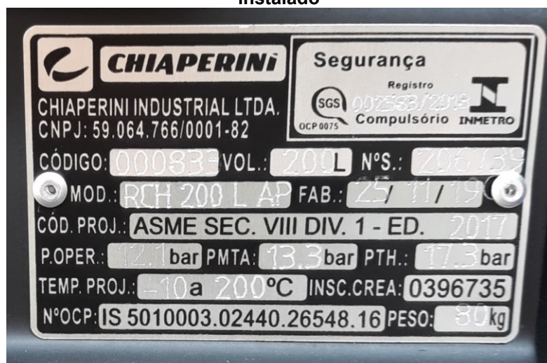
Fotografia 7 - Dados nominais do vaso de pressão acoplado ao compressor selecionado e instalado
