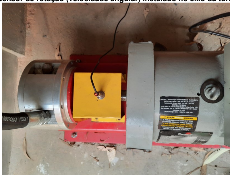
Fotografia 9 - Sensor de rotação (velocidade angular) instalado no eixo da turbina pneumática
