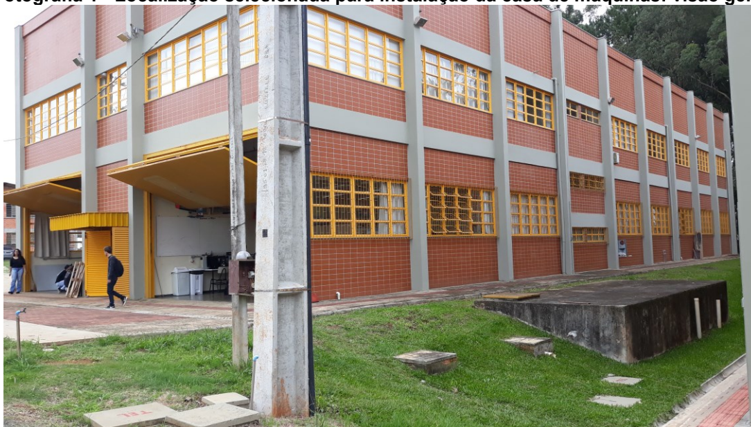
Fotografia 1 - Localização selecionada para instalação da casa de máquinas: visão geral
