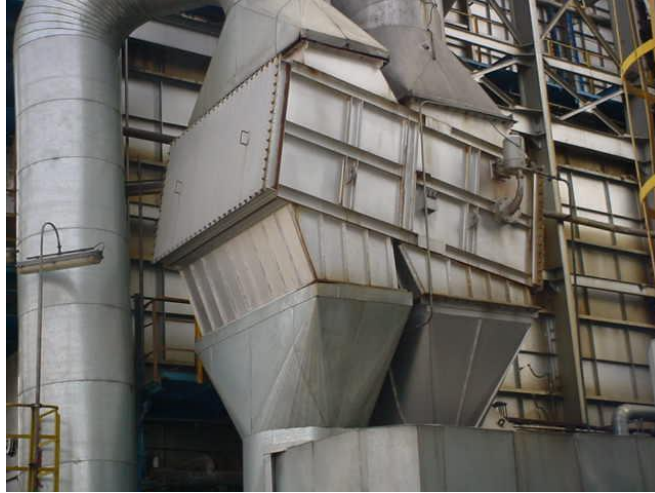
Fotografia 4 - Trocador de calor assistido por termossifões.
