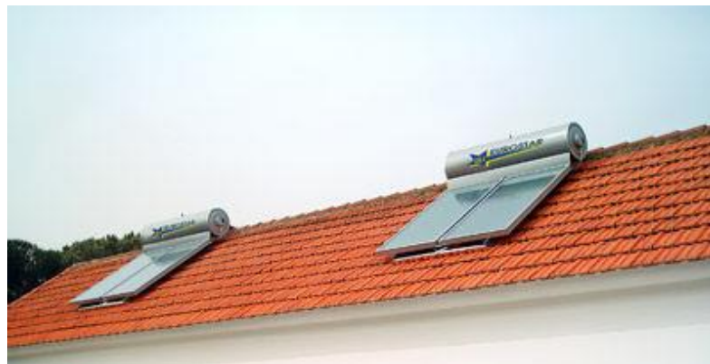
Figura 4 - Sistema de aquecimento por termossifão.
