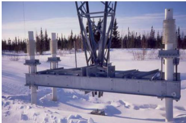
Fotografia 1 - Thermopiles aplicados na construção de uma estrutura metálica.
