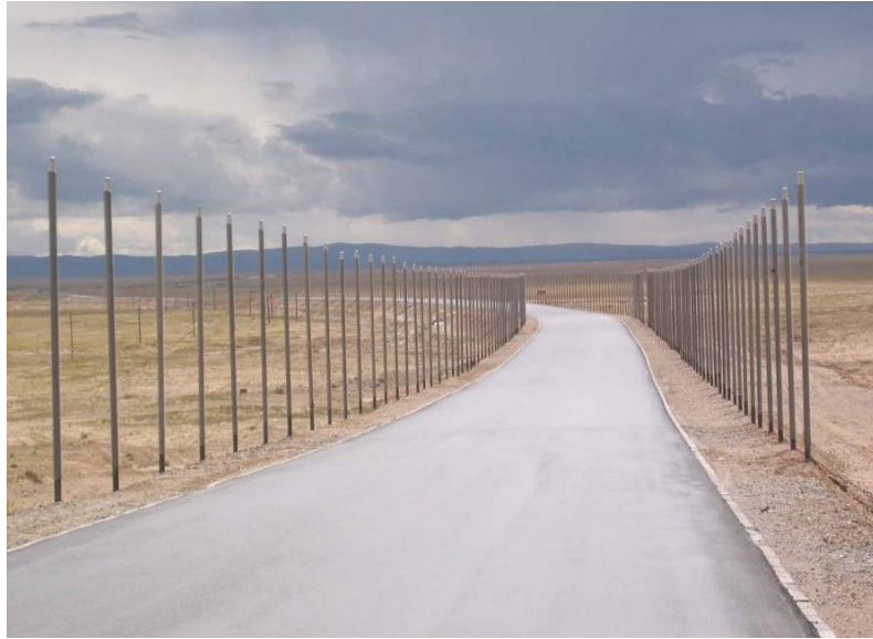
Fotografia 2 - Termossifões aplicados em estradas.
