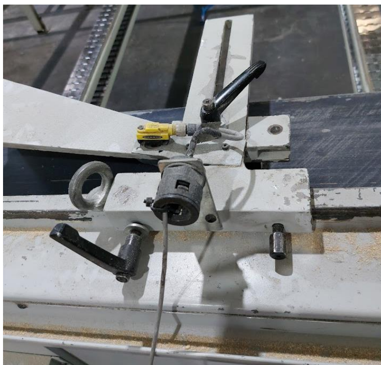
Figura 11 – Guia e Sensor Capacitivo do Descarregador.
