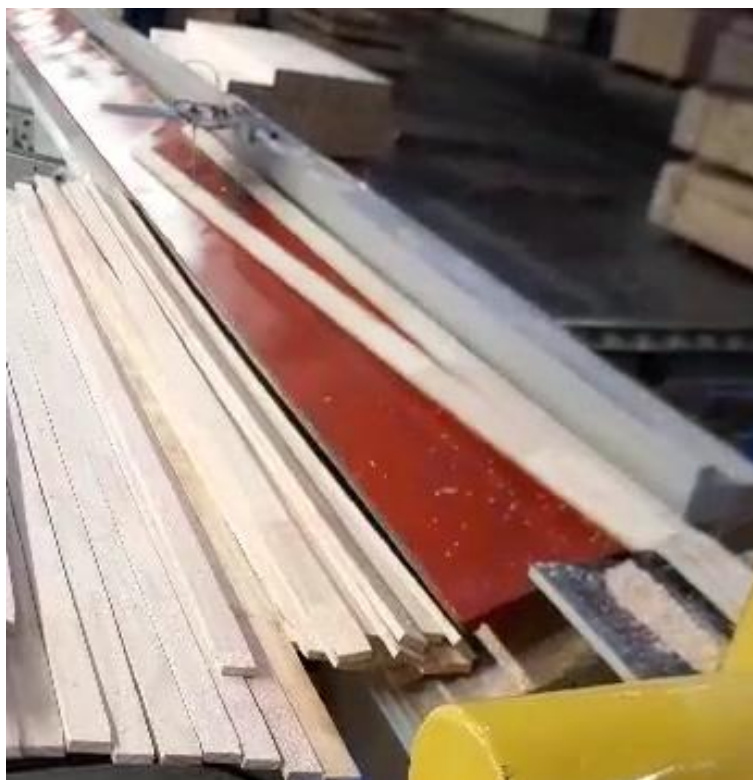
Figura 22 – Blanks de madeira sendo descarregado.
