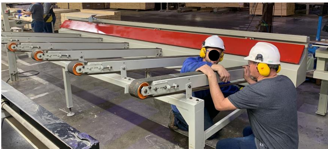
Figura 19 – Instalação do Descarregador.
