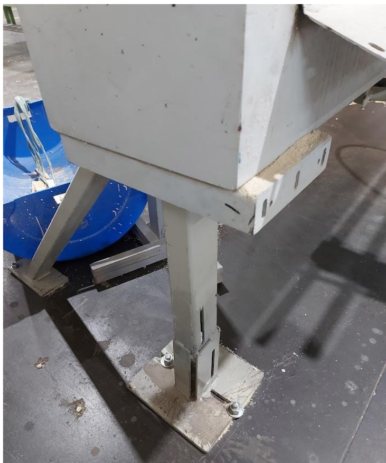
Figura 15 – Estrutura de sustentação do Descarregador.
