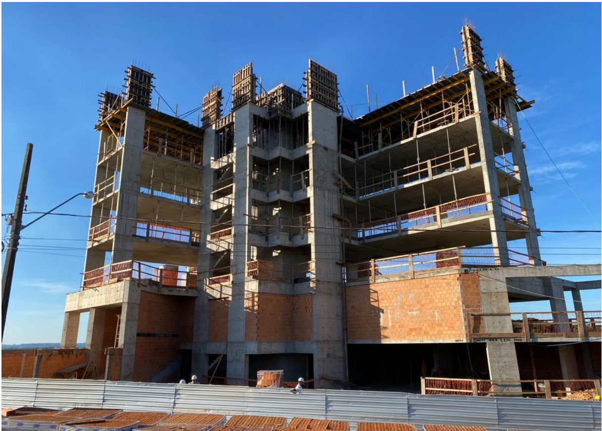
Figura 1 – Fachada de uma obra onde foi realizado o trabalho.
