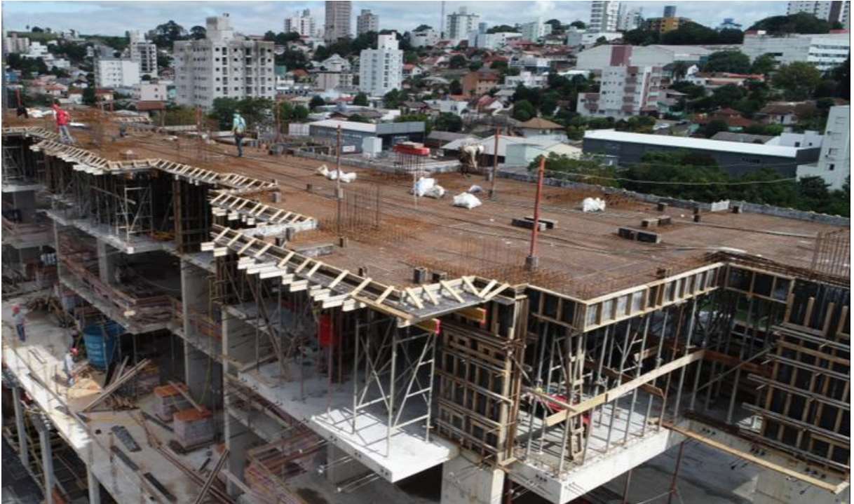
Figura 2 - Trabalhadores em uma das obras visitadas, utilizando EPI's.
