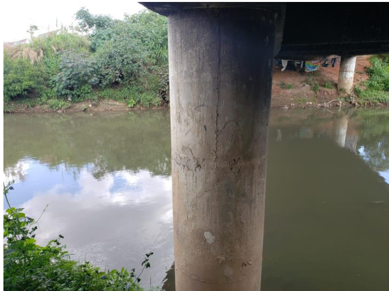
Figura 40 – Vista frontal do pilar 3.
