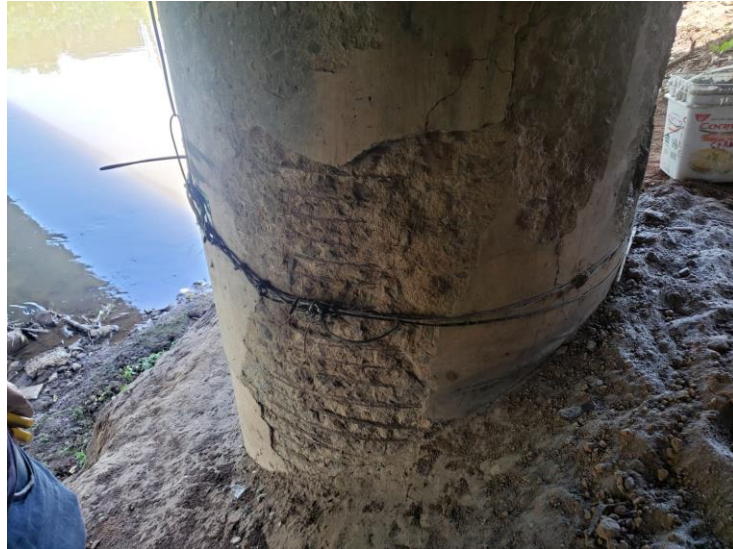
Figura 37 – Vista do pilar 1 de dentro da ponte.
