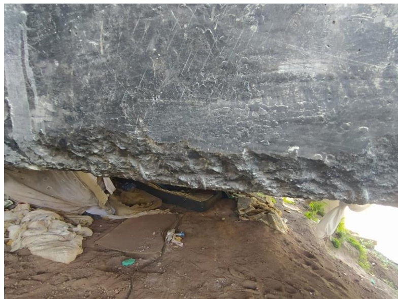
Figura 25 – Armaduras longitudinais da viga longarina 1.
