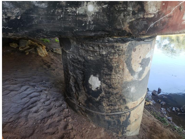
Figura 38 – Vista do pilar 1 na parte de fora da ponte.
