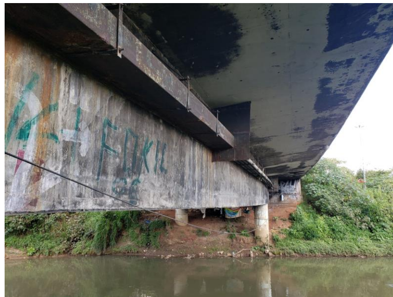
Figura 32 – Outro lado da laje próximo a viga longitudinal 2.
