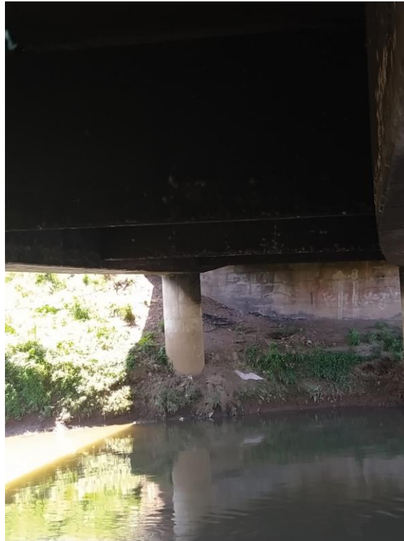
Figura 42 – Vista das transversinas.
