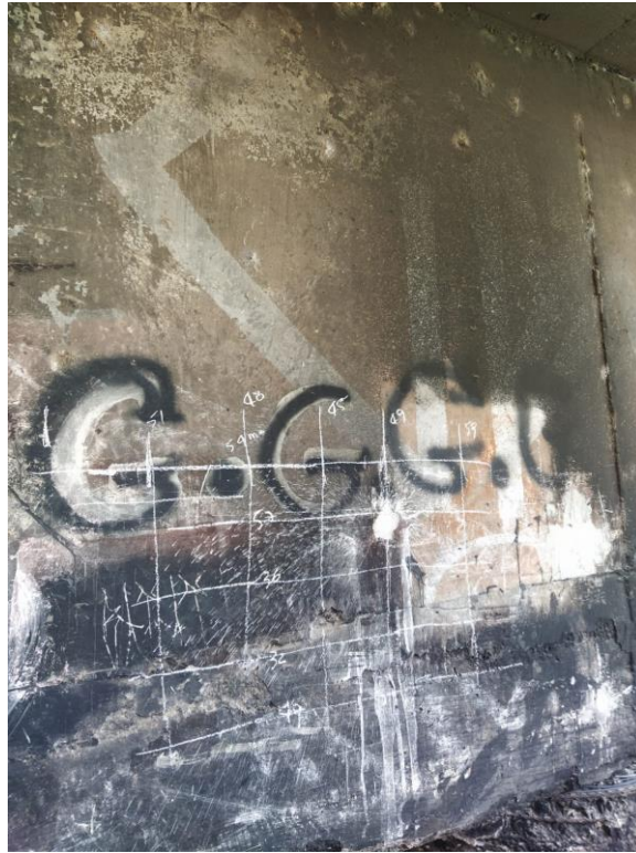
Figura 48 – Marcação das armaduras na viga longarina 1 (VL1).
