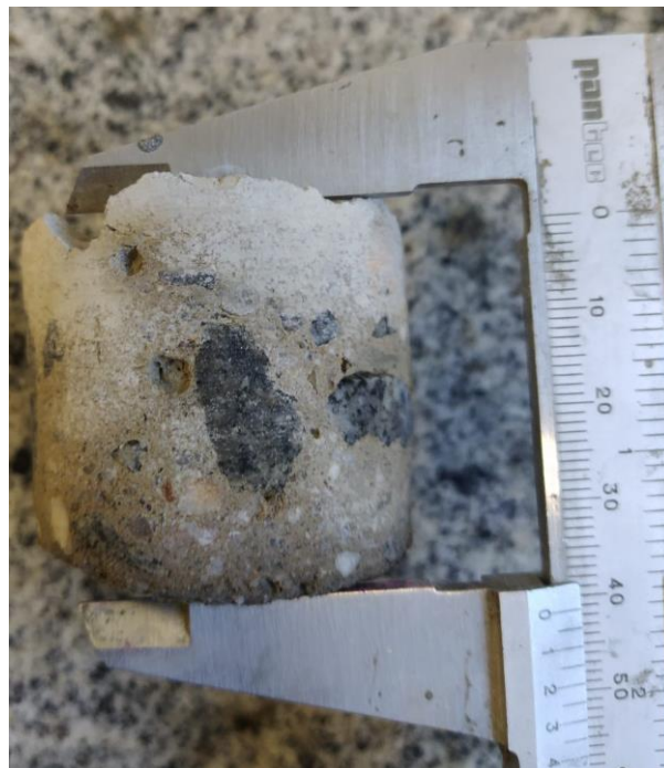
Figura 47 – Profundidade de carbonatação do corpo de prova 4.
