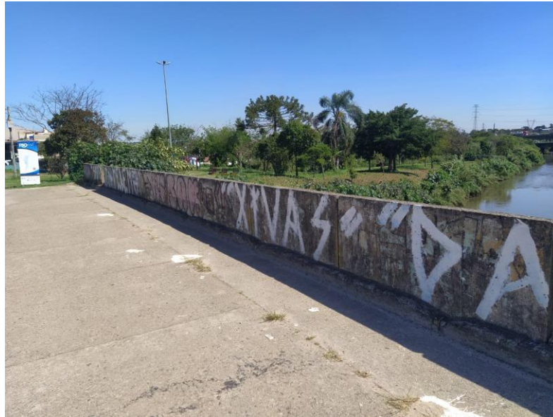
Figura 35 – Guarda Corpo na OAE.
