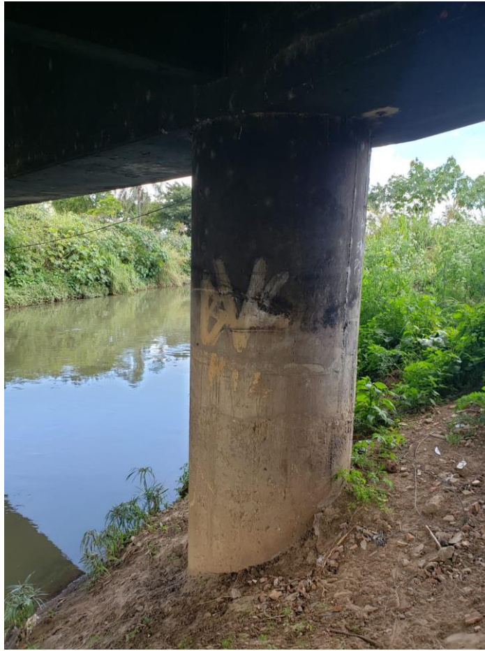
Figura 41 – Vista lateral do pilar 4.
