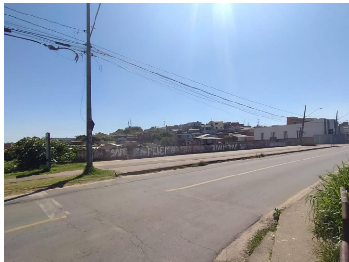
Figura 17 – Vista lateral da OAE estudada.
