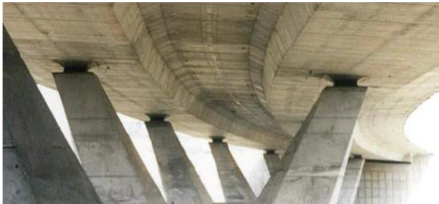
Figura 4 – Aparelhos de apoio nos pilares de uma OAE.
