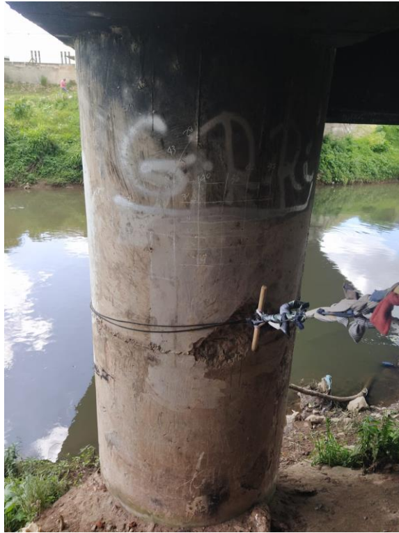
Figura 39 – Vista frontal do pilar 2.
